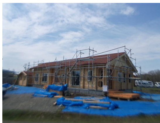
屋根仕上げ工程《2》
