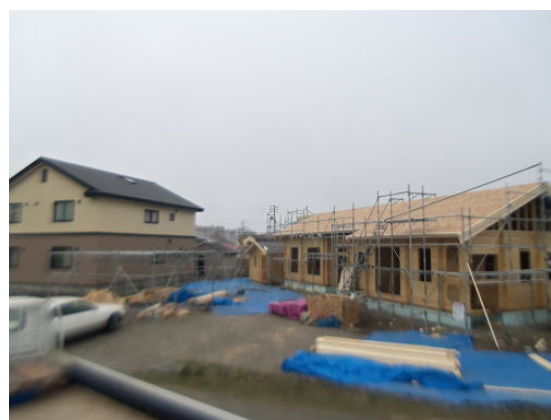
ログ躯体完成工程・棟上 (1)
