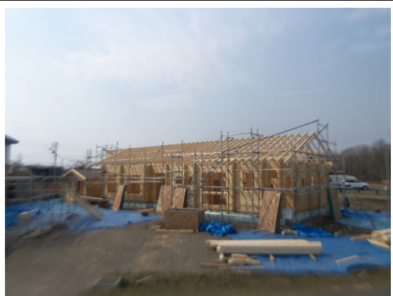
ログ躯体・屋根工程 (2)
