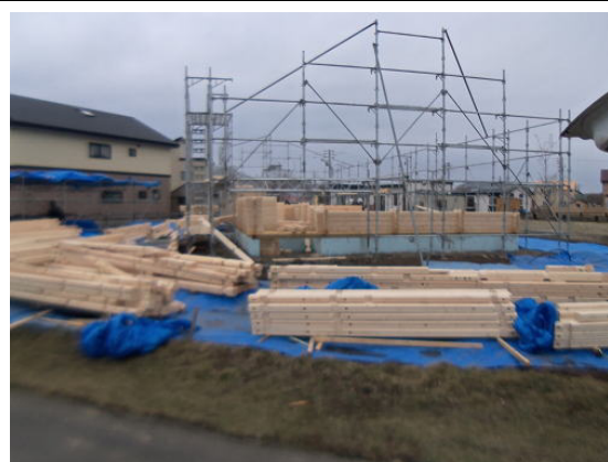
ログ部材積み上げ工程 (1)
